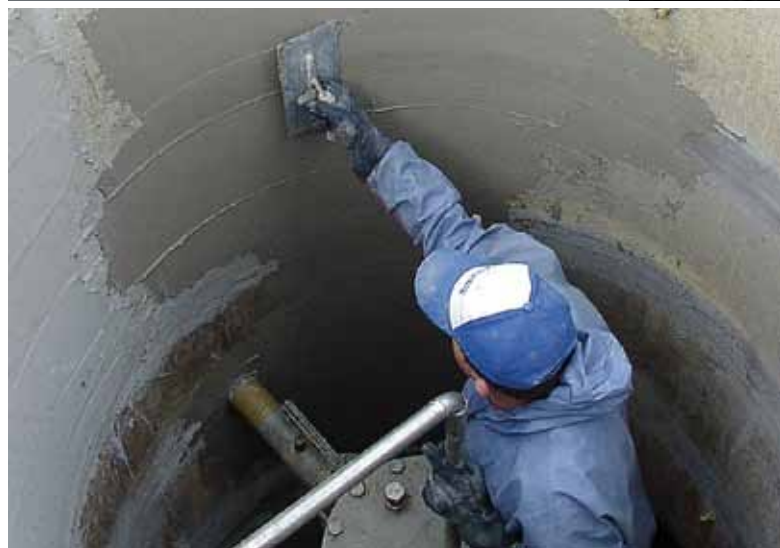
Assainissement d'une chambre avec les produits Vandex Rapid.
