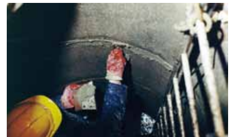
3. Reprofilage avec VANDEX RAPID M
