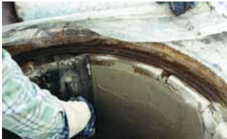
4. Revêtement sous le cadre avec VANDEX RAPID S
